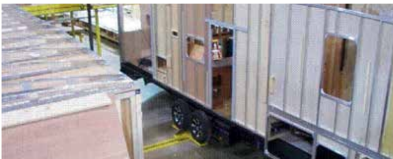
Montants de murs de côtés et fermes de toit en aluminium et centrés aux 16" ou moins
