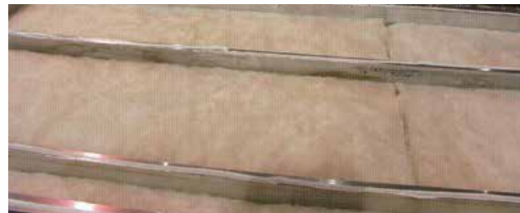
Solives de plancher en aluminium 2" x 3"
