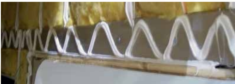
Le Silaprene épais (475 psi) garantit un contact solide entre l'enduit gélifié et le châssis en aluminium, sans laminage
