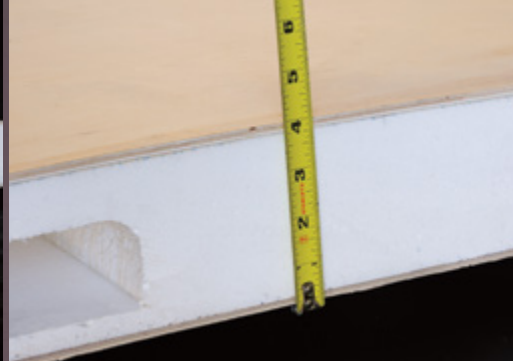
Mousse isolante de 4" d'épaisseur avec canalisation pour A/C
