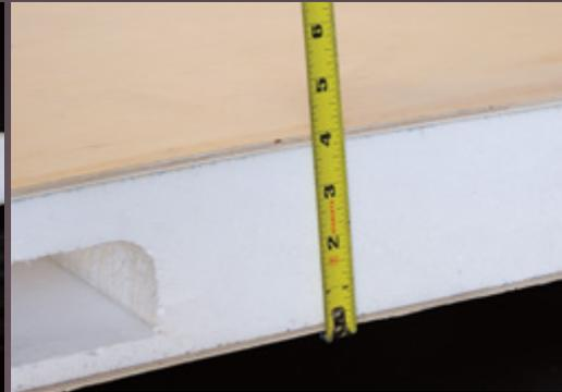
Mousse isolante de 4" d'épaisseur avec canalisations pour A/C
