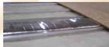
Châssis du plancher en aluminium de 3" avec canalisations de chauffage dans le plancher et plancher en contreplaqué de 5/8" emboîté et collé.
