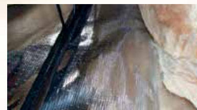
Isolation avec protection radiante avec feuille thermique R-38 pour les plafonds, le dessous de l'unité et en arrière du devant de l'unité.
