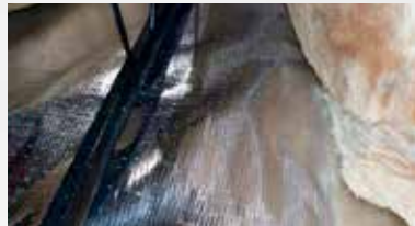
La barrière radiante Therma-foil radiante R-38 passe à travers les plafonds, les dessous d'unités et sous les caps avant.
