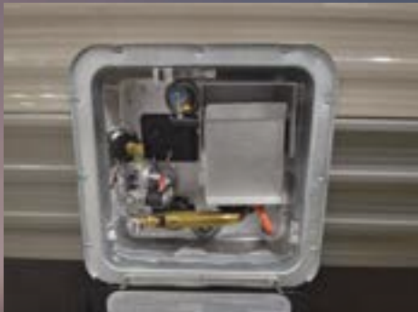
Chauffe-eau DSI gaz/électrique de 6 gallons
