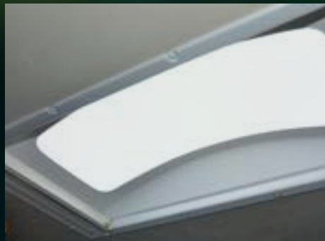
Puits de lumière avec store dans la cuisine
