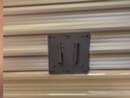
Support à TV extérieure avec connexion
