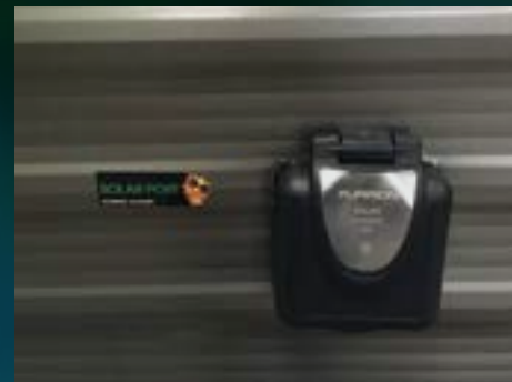
Préparé et filé pour panneau solaire
