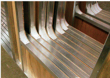
Châssis des fenêtres en aluminium
