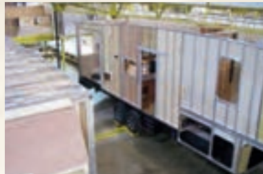
Célèbre superstructure résidentielle toute en aluminium de Cedar Creek (toit, murs latéraux et plancher) centrée aux 16" ou moins.
