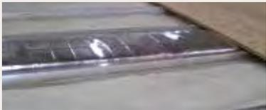
Chevron en aluminium de 3" au plancher avec canalisations de chauffage et contreplaqué de 5/8" emboîte
