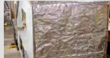
Isolation avec protection radiante avec feuille thermique R-38 pour les plafonds, le dessous de l'unité et en arrière du devant de l'unité.
