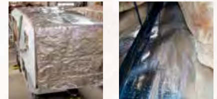
Protection radiante Therma-foil -R-38 dans le plafond, en dessous et en avant de l'unité.
