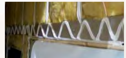
Le Silaprene épais (475 psi) garantit un contact solide entre l'enduit gélifié et le châssis en aluminium, sans laminage
